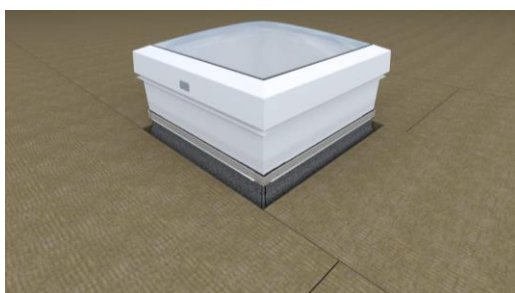
18 Sanierungsaufsetzkranz eindichten Seal renovation upstand
